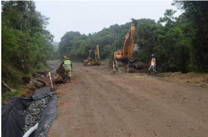
Imagen No.27: Rehabilitación y asfaltado de la vía "Y" de Celica - Pózul - Pindal
