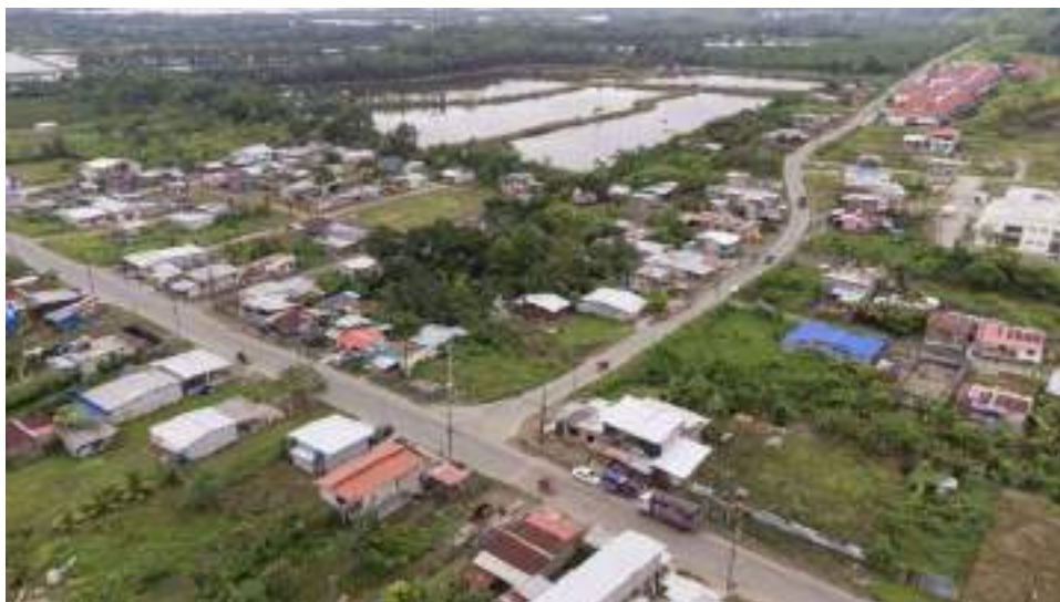
Intersección en la vía Muisne Fuente: Autoría propia, Mateo Morocho.
