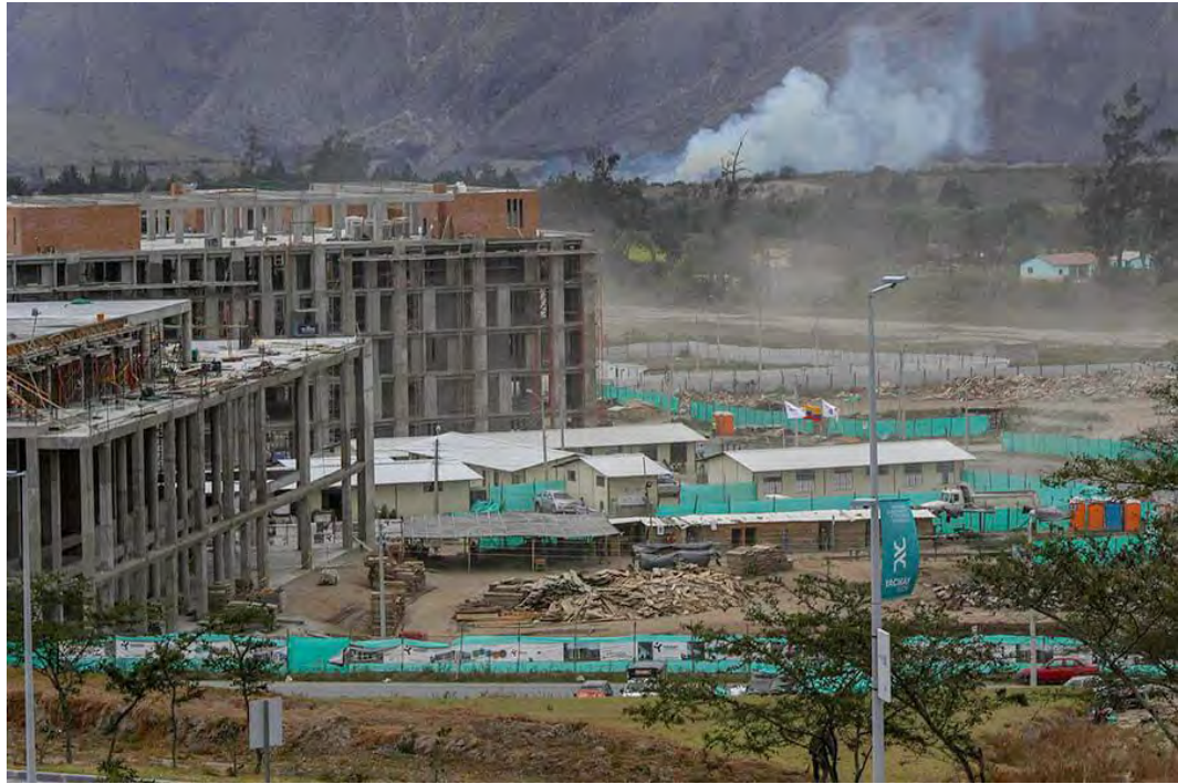
Figura 3: Estado de los edificios abandonados Yachay
